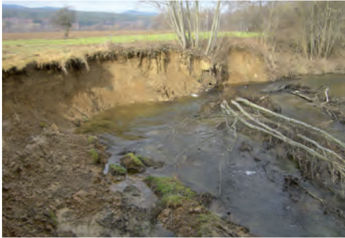
Uferanriss nach einem Hochwasser (Lafnitz).
