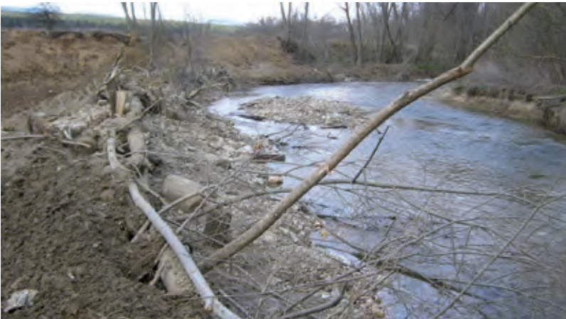
Sanierung mit ingenieurbiologische Maßnahmen.
