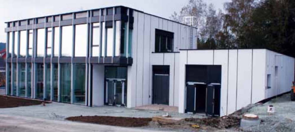
■ Energetikum Pinkafeld, Full-Scale-Versuchsanlage mit realem Nutzerverhalten
