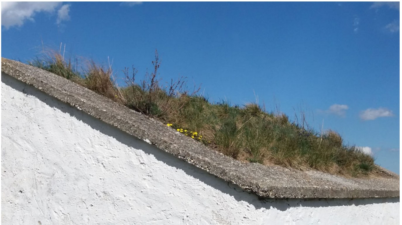
Das Dach der Hütte in Stoitzendorf © M. Gross
